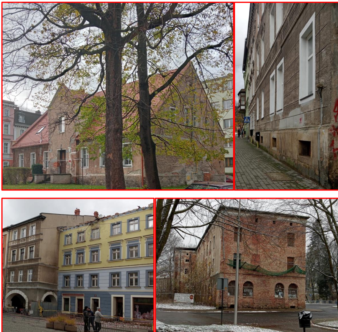
Rycina 15 Przykłady przestrzeni wymagających poprawy stanu technicznego na obszarze rewitalizacji
