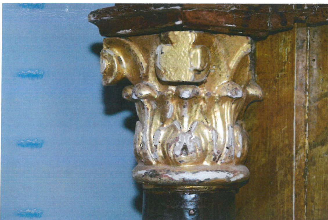
Fot. 18. Ołtarz św. Anny. Mensa. Kapitel kolumny. Ubytki, przetarcia złota do zaprawy i drewna. Braki snycerki. 01. 2022 r.
