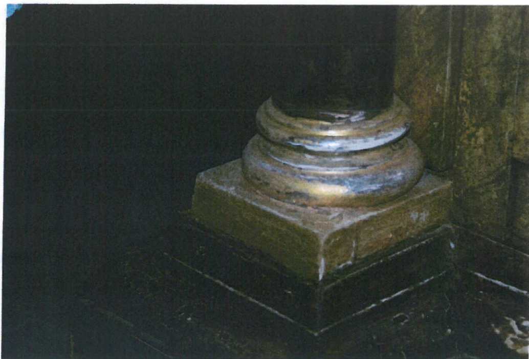
Fot. 19. Ołtarz św. Anny. Mensa. Baza kolumny. Ubytki, przetarcia złota do zaprawy. 01. 2022 r.
