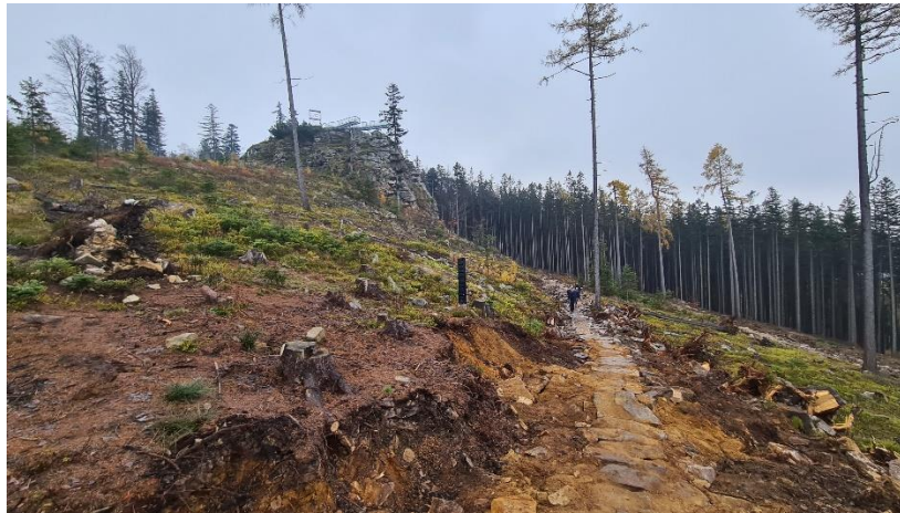
Fot. Archiwum Gminy Łądek-Zdrój. Budowa fragmentu trasy „Samotnik”.
